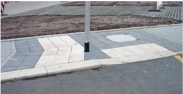
Rippen des Richtungsfeldes in Laufrichtung der Querung ausgerichtet
