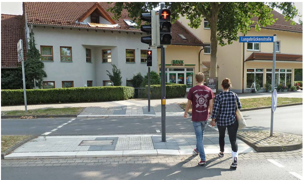
Mittelinsel an einer Querung mit differenzierter Bordhöhe
